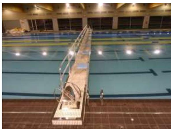
Для изменения глубины части бассейна 52x25м предусматривается подъемное дно. Подъемное дно позволяет преобразовать единый бассейн в многоцелевое сооружение, образуя дно различной глубины, в зависимости от проводимой в бассейне деятельности (плавание, водное поло, синхронное плавание, аквааэробика, обучение плаванию и т.д.).
